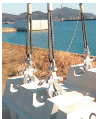
※吊鉄筋直掛け使用
