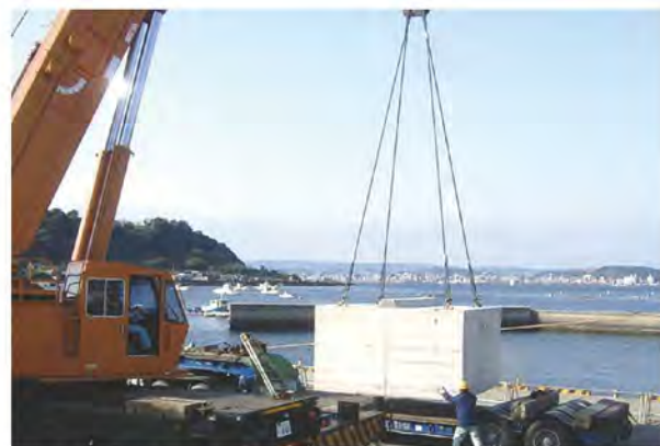
方塊ブロック転置状況
