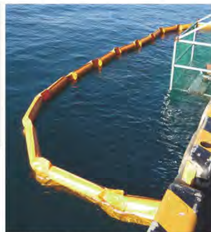
防舷材取付工事時設置状況
