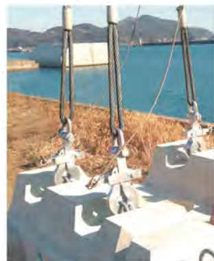
※吊鉄筋直掛け使用
