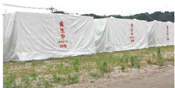
根固方塊ブロック
