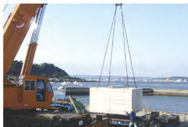
方塊ブロック転置状況
