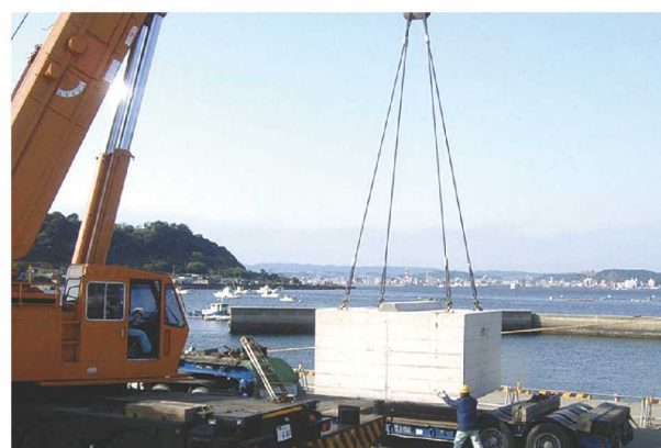
方塊ブロック転置状況
