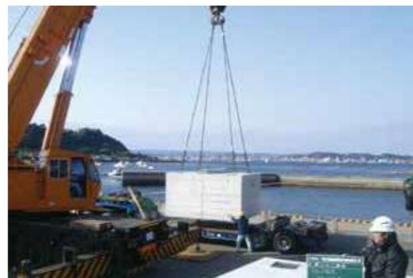
方塊ブロック転置状況
